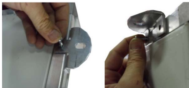
Figura 1 - Fijación de los soportes suministrados
