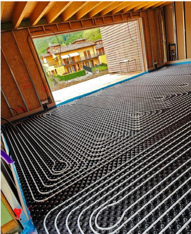
Per l'impianto termico è stato scelto un **sistema radiante a pavimento di tipo TF certificato CAM di RDZ**, utilizzato sia per il riscaldamento invernale che per il raffrescamento estivo: si tratta di un pannello bugnato in polistirene espanso prodotto in conformità alla normativa UNI EN 13163, rivestito con pellicola termoformata in HIPS spessore 0.6 mm per maggiore resistenza alla deformazione da calpestio e dotato di incastri sui quattro lati per facilitare l'accoppiamento.
