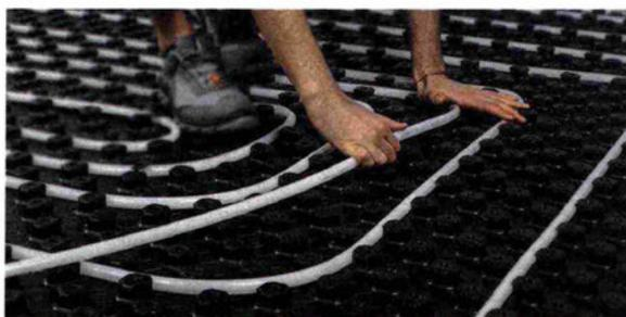
↑ Il tubo monostrato **Volex di Geberit** ([www.geberit.it](http://www.geberit.it)) è realizzato in PE-RT II (polietilene a resistenza termica maggiorata), con barriera all'ossigeno che lo rende impermeabile e resistente. Ha diametro di 16 o 20 mm e si può abbinare a **pannelli isolati sagomati o lisci**, di diversi spessori.
